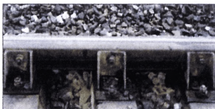
Рис.7.23 Одноболтовый вкладыш.
