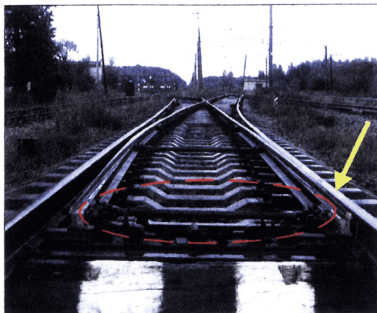
Рис.7.17. Место замера отставания остряка от рамного рельса.
