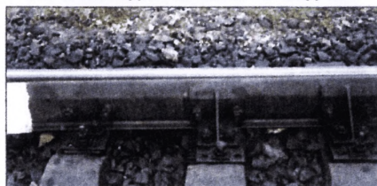
Рис.7.24. Двухболтовый вкладыш.
