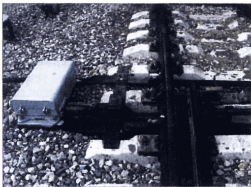
Рис. 7.4. Переводной механизм.
