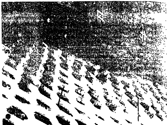
Рис. 9. Общий вид конструкции из георешеток типа Armater на откосе.
