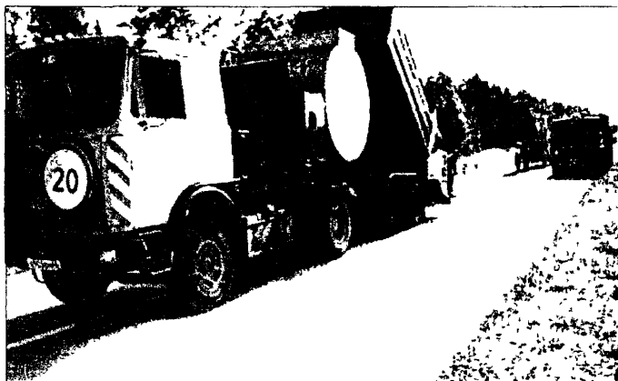
Рис. 4.1. Устройство поверхностной обработки машиной с синхронным распределением материалов типа «Чипсилер».
