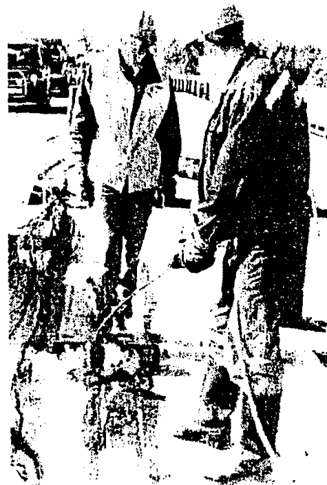
Рис. 5.4 Наклейка рулонной гидроизоляции
