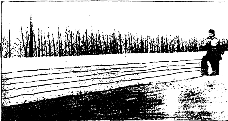
Рис.3. Обрез снежного вала после расчистки заноса роторным снегоочистителем
