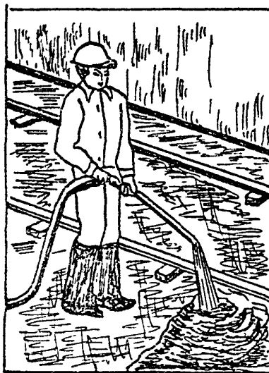
Рис. 5. Нанесение раствора соплом при устройстве полимерцементных стяжек
