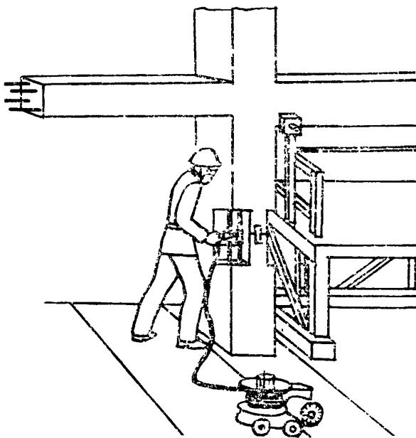
Монтажник включает генератор постоянного тока для питания полуавтоматов и переносным регулятором устанавливает требуемое напряжение. Электросварщики Э<sub>1</sub> и Э<sub>2</sub>, находясь по углам колонны, подают конец электродной проволоки в плавильное пространство формы и возбуждают дугу под слоем флюса. В первый период сварка ведется при напряжении 40-45 В, а затем, по мере зас
