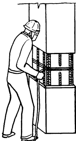
Монтажник  $M_1$  размечает места установки накладных стержней из арматурной стали, а монтажник  $M_2$  производит временное закрепление стержней электроприхваткой. До освобождения рамы от группового кондуктора монтажник  $M_2$  должен сварить примерно 60% стержней
