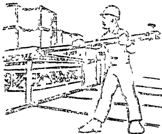
Монтажники  $M_3$  и  $M_4$  отсоединяют продольные рамы выдвигают их в балки индикаторных рам и закрепляют. Затем, разъединив поперечные рамы, монтажники выдвигают их в поперечные балки РШИ, а откидные поворачивают на индикаторной раме относительно узлов крепления и закрепляют на раме. После этого они привязывают оттяжки к РШИ
