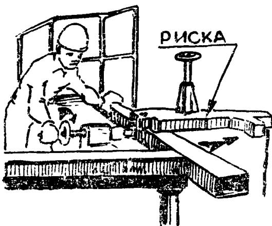
Монтажники  $M_1$  и  $M_2$  по сигналу геодезиста вращением штурвала механизмов поперечного перемещения устанавливают "плавающую" шарнирно-индикаторную раму в направлении продольной базовой оси до совпадения визирной оси теодолита с рисками на хомутах. Затем геодезист переносит и устанавливает теодолит в створе поперечной базовой оси.
