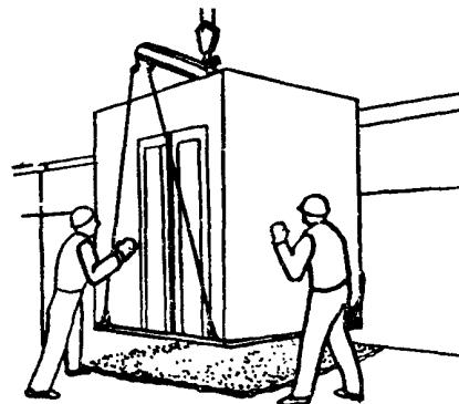
5 ВЫВЕРКА И РАССТРОПОВКА КАБИНЫ; 4,5 мин;  $M$ ,  $M_1$ ,  $M_2$ ; пом, отвес-рейка, лопата
