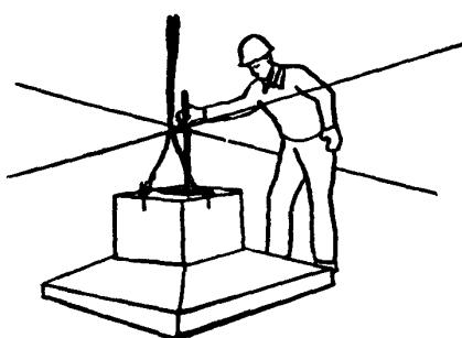
Монтажник  $M_1$  закрепляет отвес в месте пересечения проволочных осей и вместе с монтажником  $M_2$  при натянутом стропе рихтует фундамент, добиваясь полного совмещения шнура отвеса с рисками на верхней грани стакана. Затем он подает команду машинисту крана ослабить строп и, вертикально установив шаблон на дне стакана, по совпадению риски на шаблоне с разбивочной осью здания проверяет правильность установки фундамента по высоте
