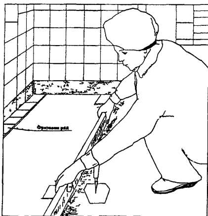
Рисунок 15 – Разравнивание раствора рейкой по маякам
