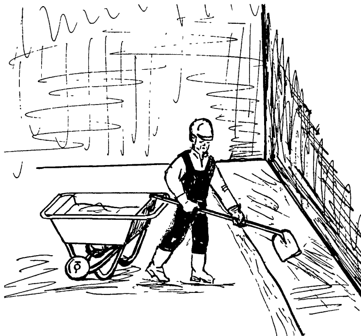
Рисунок 11 – Укладка раствора под мраморные плиты
