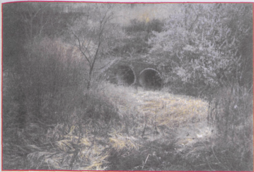
Наличие травы высотой более 15 см и древесно-кустарниковой растительности у оголовков водопропускных труб
