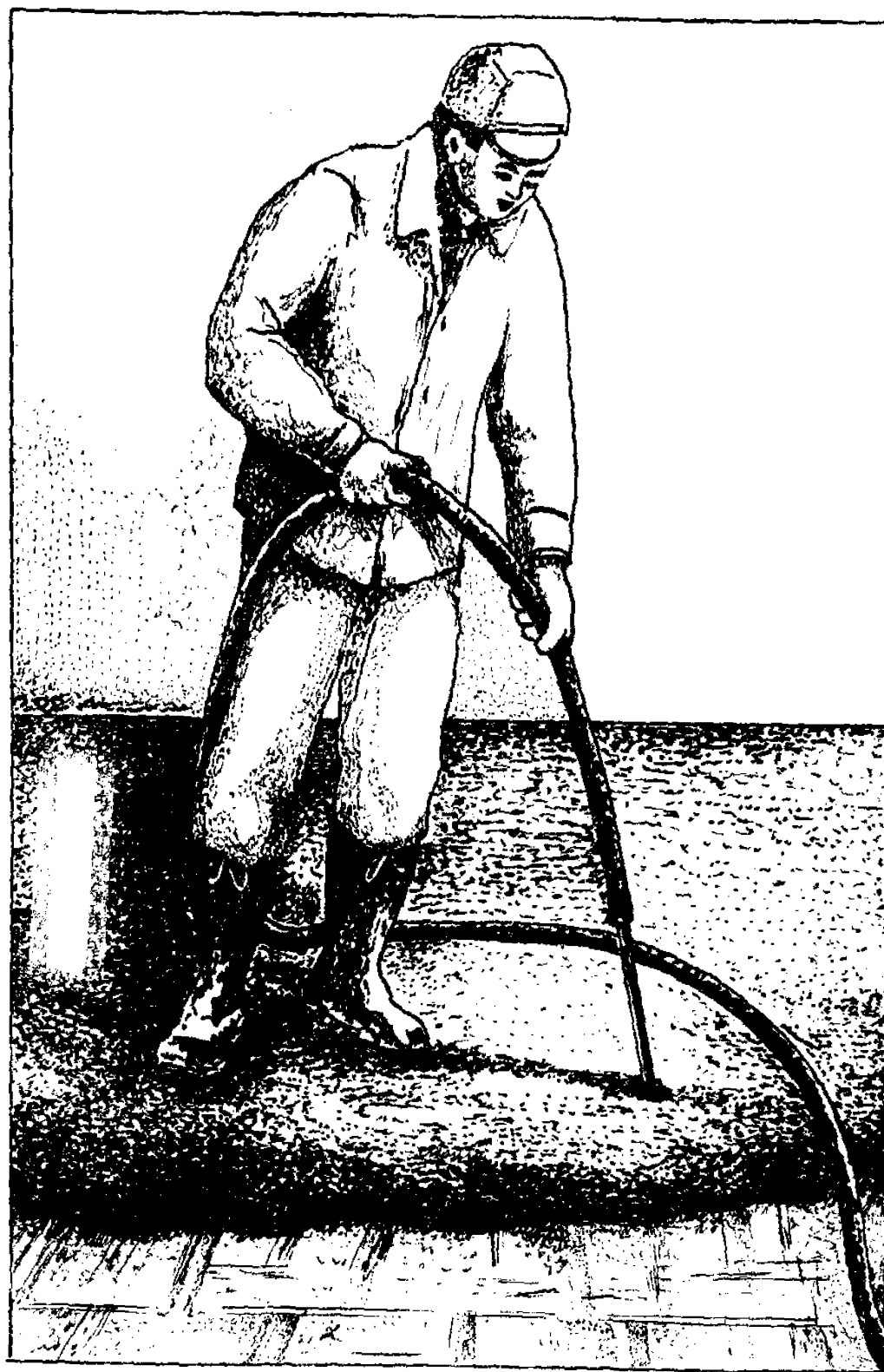
Рис. 1. Заливка самовыравнивающегося раствора
