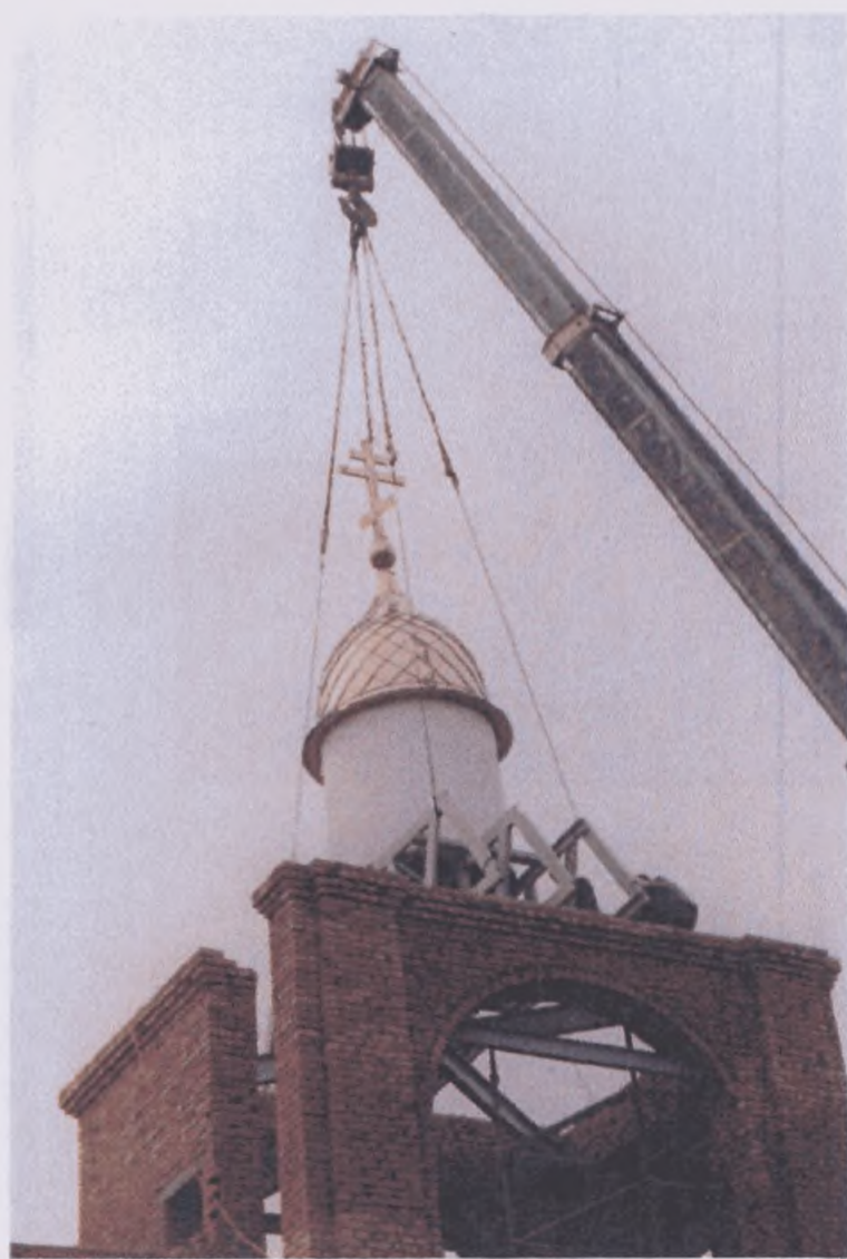
Монтаж венчающей части звонницы
