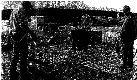
Рис. 6. Метод укладки плит «FOAMGLAS READI BOARD» по нанесенному полосами битуму
