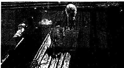
Рис. 5. Метод укладки плит «FOAMGLAS» Т4 и S по пароизоляционному слою
