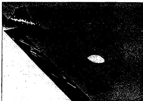
Рис. 5. Сопряжение (нахлестка) изоляционных слоев на примыкании к воронке внутреннего водостока
