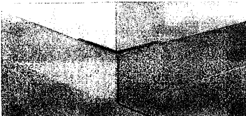
Рис. 7. Усиление водоизоляционного слоя из рулонного материала на примыкании к парапету (стене)
