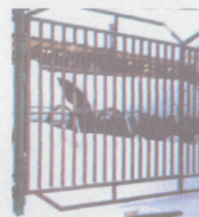
Заполнение штакетником из прямоугольных труб 28x25x1,5
