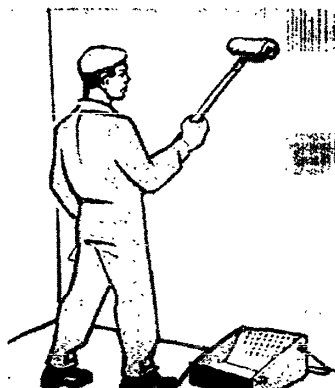
Рисунок 19 – Нанесение олифы на поверхность
