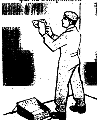
Рисунок 22 – Нанесение шпатлевки на поверхность
