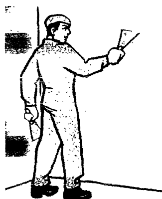
Рисунок 4 – Заполнение шпатлевкой трещин
