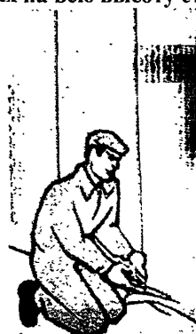
Рисунок 13 – Прирезка наклеенных полотнищ обоев у пола
