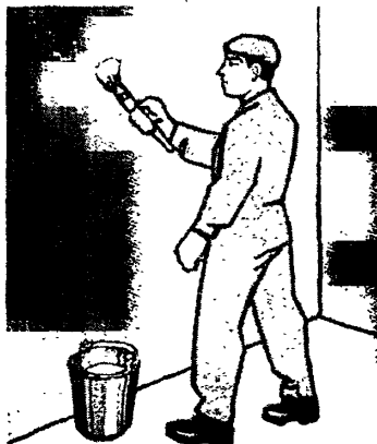
Рисунок 5 – Огрунтовка подмазанных мест
