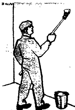
Рисунок 8 – Нанесение клейстера на всю поверхность стены
