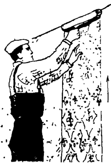
Рисунок 16 – Разглаживание обоев валиком
