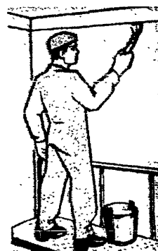
Рисунок 10 – Нанесение клейстера по периметру стен, оконных и дверных проемов, а также в углах на всю высоту стен
