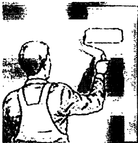
Рисунок 34 – Окрашивание обоев
