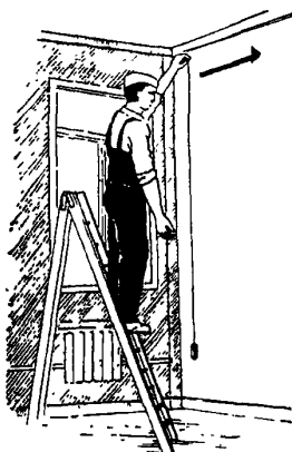
Рисунок 14 – Провешивание стен в углах
