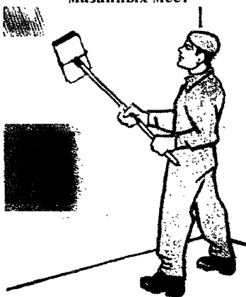
Рисунок 23 – Шлифовка поверхности шарнирными терками
