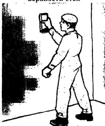
Рисунок 21 – Выравнивание поверхности колодкой со шкуркой
