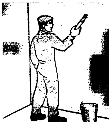
Рисунок 20 – Проолифка подмазанных мест
