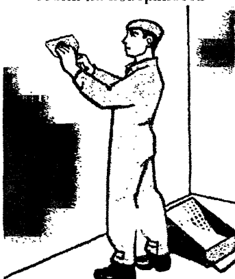
Рисунок 6 – Нанесение шпатлевки на поверхность
