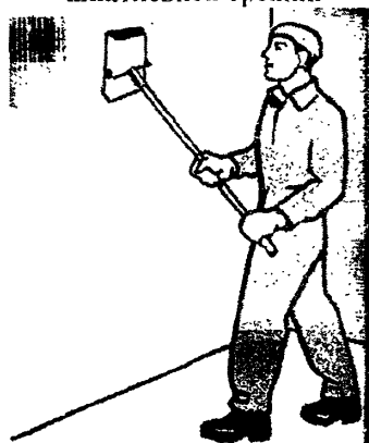
Рисунок 7 – Шлифовка поверхности стен шарнирными терками
