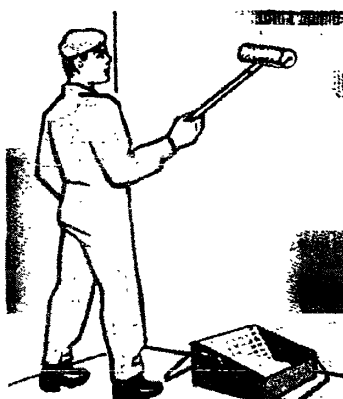
Рисунок 3 – Нанесение грунтовки на поверхность
