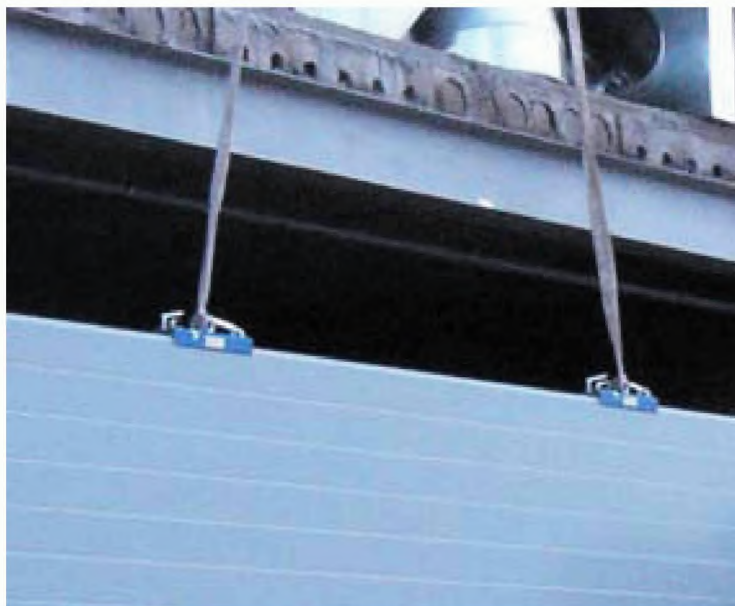
Рисунок 12б – Транспортирование и укладка стеновых панелей на месте монтажа при помощи струбцин
