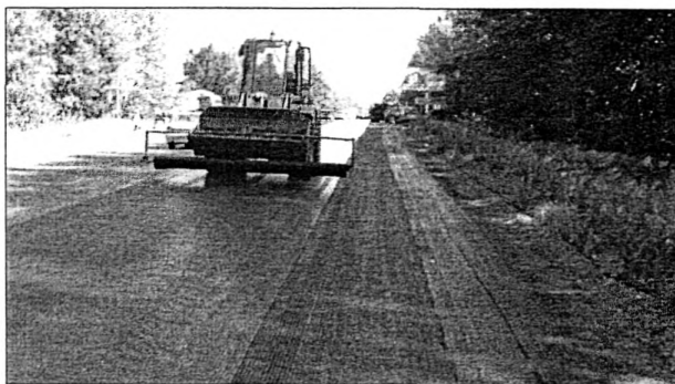
Рисунок 4. Пример укладки геосетки на основание
