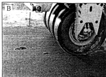
Рисунок 3. Битумные пятна на поверхности покрытия
