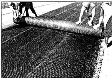
Рисунок 5. Укладка геосетки вручную
