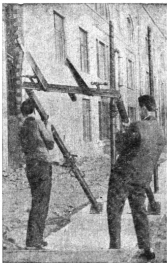
Рис. 44. Установка телескопических стоек с балочными струбцинами
