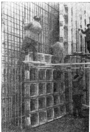
Рис. 38. Установка опалубки стены водоводного тоннеля из деревянных щитов конструкции ЦНИИОМТП
