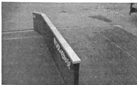
Рисунок Е.6 — Кинк — место изгиба на грани или рейле
