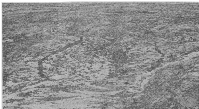
Рис 29. Провальные воронки на откосе намыва золошлакоотвала Интинской ТЭЦ в результате оттаивания мерзлоты и замытого льда (июль, 1980 г.).
