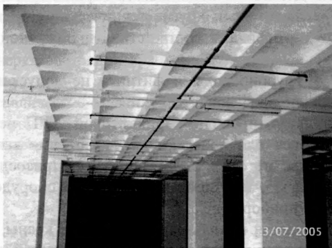
Рисунок 4.1 – Пример монтажа трубопроводов
