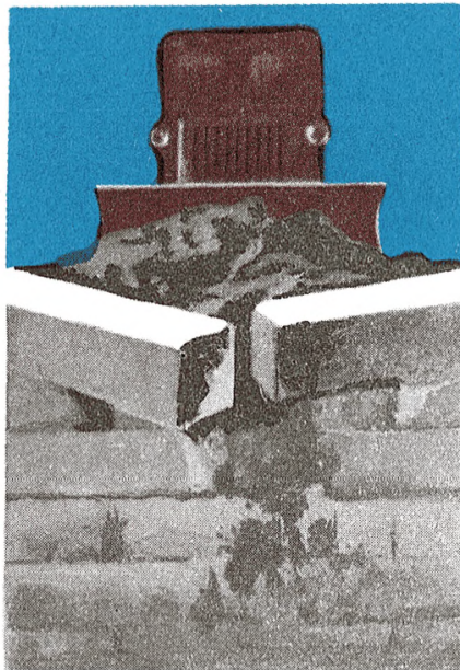
Засыпай после перекрытия подвала
