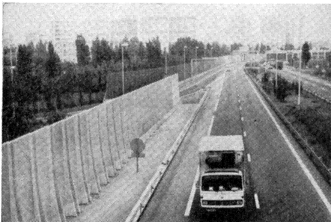
Рис. 13. Экраны из сборных железобетонных элементов, защищающие от шума многоэтажную застройку, расположенную на расстоянии 50 м от магистрали (протяженность 1,7 км, высота 5,3 м, Франция)
