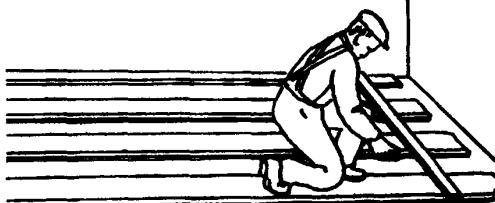
Плотник, выверив маячные лаги, выверяет и выравнивает промежуточные. При необходимости он увеличивает или уменьшает толщину подкладок, а также с помощью шаблона проверяет расстояние между лагами. Убедившись в правильности укладки лаг, плотник временно расшивает их досками для предохранения от смещения
