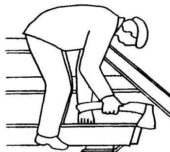
Плотники  $\Pi_1$  и  $\Pi_2$  выбирают четверть в торцах рядовых досок для соединения с фризовыми досками
