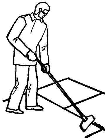
4 ОГРУНТОВКА ПОВЕРХНОСТИ ПЛИТ; 2,5 мин;  $\Pi_1$ ,  $\Pi_2$ ; капроновые щетки, ванночки с сетками, пылесос
