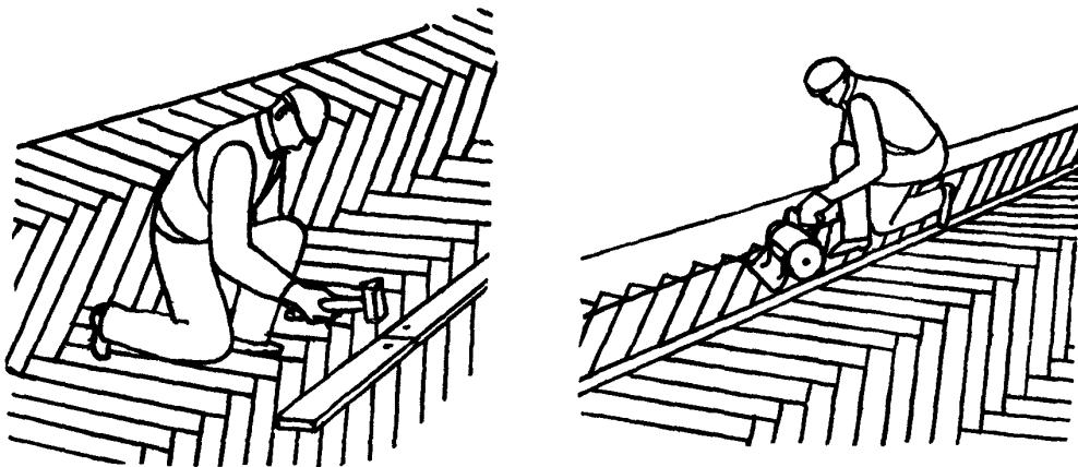
Паркетчики прибивают направляющие рейки на расстоянии от шнура равном длине электропилы от хвостовой ее части до диска. Затем подключают электропилу к источнику питания, включают ее и обрезают торцы паркета, двигая пилу вдоль направляющей рейки. Обрезки паркета собирают в ящик, опилки подметают метлой, убирают на тележку и вывозят из помещения, а затем снимают направляющую рейку
