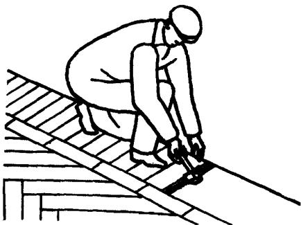
Паркетчики начинают укладку фризовых клепок от угла с таким расчетом, чтобы стена находилась слева от них. Укладку они ведут на себя. Гребень клепки вводят в паз предыдущей клепки. В шпунт клепки длиной до 300 мм забивают два гвоздя, а при большей длине – три гвоздя. Горизонтальность уложенного фриза проверяют рейкой и уровнем. При необходимости производят пристройку клепок ручным рубанком и притеску стамеской
