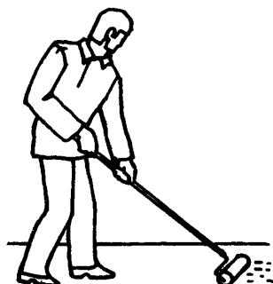
Облицовщик  $O_2$  погружает валик в ванночку, отжимает о сетку излишки состава, после чего наносит огрунтовочный состав на обрабатываемую поверхность, прокатывая валик перед собой вперед и назад
