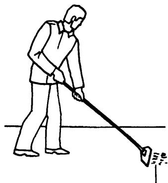
Облицовщик  $O_1$  стальным скребком очищает поверхность стяжки от грязи и напылов раствором. Облицовщик  $O_2$  метлой выметает мусор из помещения
