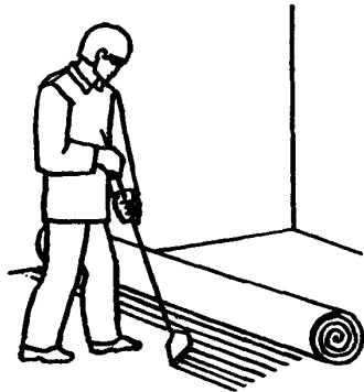
Облицовщик  $O_1$  разравнивает клей гребенкой, формируя слой толщиной 0,6–0,7 мм. При этом он оставляет на продольных стыках полотнищ ненамазанные полосы шириной 8–10 см
