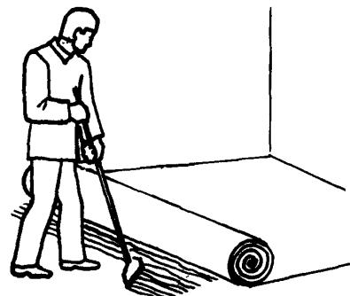
Облицовщик О<sub>1</sub> гребенкой разравнивает клей, формируя слой толщиной 0,6–0,7 мм. При этом он оставляет на продольных стыках полотнищ ненамазанные полосы шириной 8–10 см
