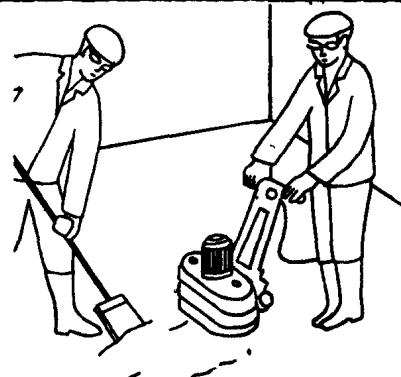
Облицовщики  $O_2$ ,  $O_3$  и  $O_4$  круговыми движениями мозаично-шлифовальных машин обрабатывают поверхность пола. Затем облицовщик  $O_1$  фанерной лопатой убирает шлам и смывает его остатки водой из шланга. Облицовщик  $O_2$  посыпает опилками промытый пол, а облицовщики  $O_3$  и  $O_4$  фанерными лопатами собирают опилки, после чего облицовщик  $O_1$  сметает их веником
