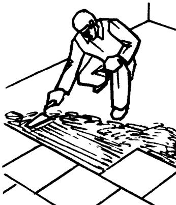
Облицовщики правилами и лопатками разравнивают раствор до уровня, превышающего на 2–3 мм проектную толщину подстилающего слоя (30–40 мм)
