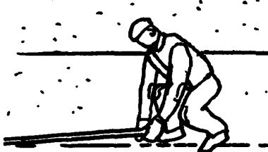
Бетонщики Б<sub>1</sub> и Б<sub>2</sub> берут концы реек, утопленных в растворе и поднимают их вверх, после чего относят к новому месту укладки
