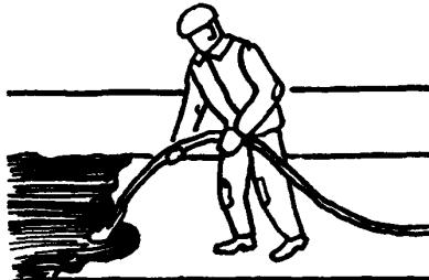
Бетонщик  $B_4$ , поддерживая левой рукой шланг снизу, правой держит его у выходного отверстия и наносит на основание раствор параллельными полосами шириной 30–40 см. Бетонщик  $B_3$  переносит шланги
