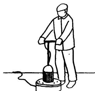
Маляр  $M_3$  включает шлифовальную машину и обрабатывает поверхность основания в местах расшищих и заделанных трещин (в труднодоступных местах он выполняет эту операцию скребком)
