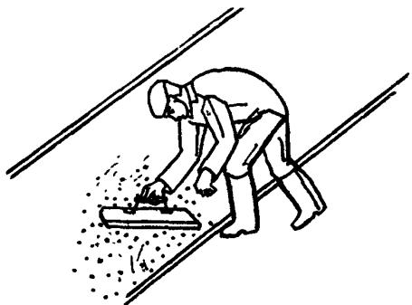
Облицовщики с помощью гладилок и кельм заглаживают поверхность уложенного полимербетонного покрытия пола, увлажняя бетон водным раствором поливинилакетатной эмульсии (состав 1:6) без посыпки поверхности цементом
