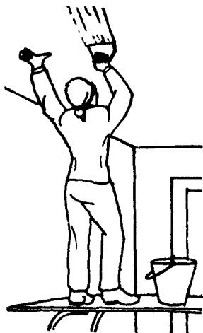
Расшивку трещин производят за два движения. Малляр  $M_1$ , упираясь одной рукой в потолок, другой расшивает узким шпателем трещину в штукатурке на глубину около 2 мм. При этом плоскость шпателя должна быть наклонена вправо под углом примерно  $60^\circ$  к плоскости потолка. При по-
