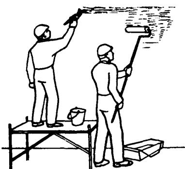
Маляр M<sub>1</sub> кистью-ручником наносит полосы колера по верху стен и периметру оконных и дверных проемов. Маляр M<sub>2</sub> погружает валик в ванночку с колером и, прокатив его по сетке для снятия излишков, наносит колер на поверхность стен движениями валика сверху вниз или снизу вверх, перекрывая кромки наносимых полос на 4-5 см
