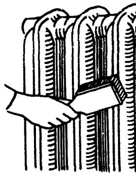
Малляр, работая шпателем как скребком, легкими скользящими ударами снимает с металлических поверхностей отвердевшие брызги раствора и окалину.
