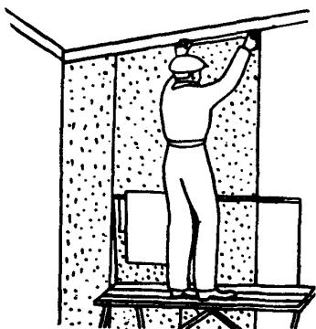
Маляр  $M_1$  берет с перекладины столика-подмостей намазанное клейстером полотнище, разворачивает его и прикладывает верхний край к линии верха обоев. Маляр  $M_2$ , ориентируя полотнище по намеченной линии, приклеивает нижнюю часть полотнища
