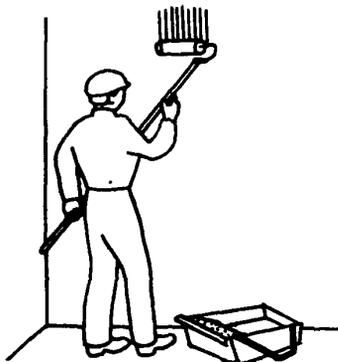
Маляр  $M_1$  погружает валик в ванночку с клеевым составом и, прокатив его по сетке для снятия излишков, наносит состав на поверхность стены. Нанесенный состав выдерживают в течение 20 мин. Маляр  $M_2$  готовит клеевой состав и подносит его к рабочему месту
