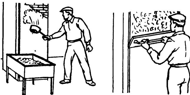
Штукатуры Ш<sub>1</sub> и Ш<sub>2</sub> набирают раствор из ящика штукатурными ковшами и движениями руки снизу вверх с поворотом наносят грунт на поверхность колонн. Затем они разравнивают грунт полутерками, передвигая их по правильным рейкам. Работу на высоте более 1,5 м они выполняют с инвентарных щитов, уложенных на столики-подмости
