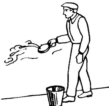
Штукатур Ш<sub>1</sub>, периодически окуная кисть в воду, обрызгивает поверхность стен или перегородок. Затем ковшом набирает из ведра раствор и быстрыми резкими движениями набрасывает раствор на поверхность. Раствор наносят сверху вниз и слева направо полосами шириной 80-150 см. Каждая последующая порция наносимого раствора должна соприкасаться с ранее нанесенной
