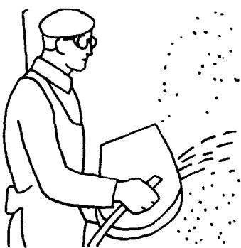
Штукатуры Ш<sub>1</sub> и Ш<sub>2</sub> работают самостоятельно. Каждый из них берет левой рукой пневматическую машинку, ставит ее в наклонном положении на ведро загрузочным отверстием вверх, а правой рукой ковшом набирает из ведра приготовленный раствор и наполняет им бак машинки на 2/3 его объема. Затем штукатуры становятся вполоборота к стене на расстоянии 80–100 см
