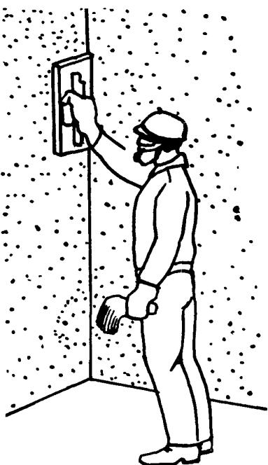
Места, недоступные для механизированной затирки, штукатур Ш<sub>4</sub> затирает вручную круговыми движениями деревянной терки. При этом поверхность стены увлажняют рогожной кистью или с помощью форсунки от краскопульта. В верхней части стены штукатур работает, стоя на столике
