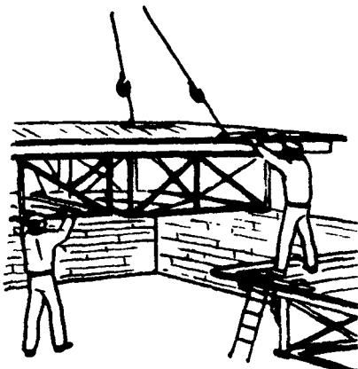
По сигналу такелажника  $T_1$  машинист крана приподнимает подмости на 20–30 см, а такелажник, находясь на безопасном расстоянии, визуально проверяет натяжение тяг. Убедившись в надежности строповки, он дает команду машинисту крана переместить подмости к месту установки. Монтажник  $M_1$  и такелажник  $T_2$  принимают подмости и ориентируют их над местом установки
