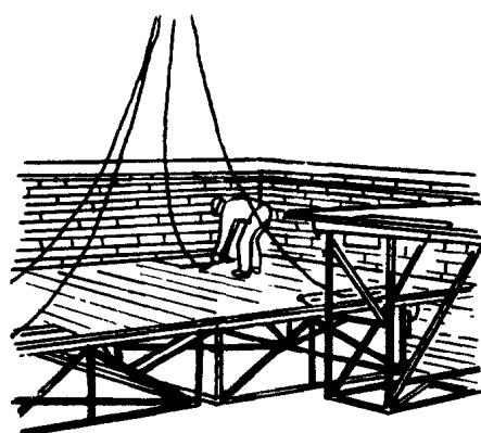
Поднявшись по приставной лестнице на подмости, монтажник  $M_2$  и такелажник  $T_3$  стропят их за четыре внешние петли тяг, затем переходят на стоящие рядом подмости, подают сигнал машинисту крана на подъем и следят за равномерностью раскрытия опор и горизонтальностью подмостей. При подъеме подмостей опоры изменяют свое положение (раскрываются), поворачиваясь на  $90^\circ$
