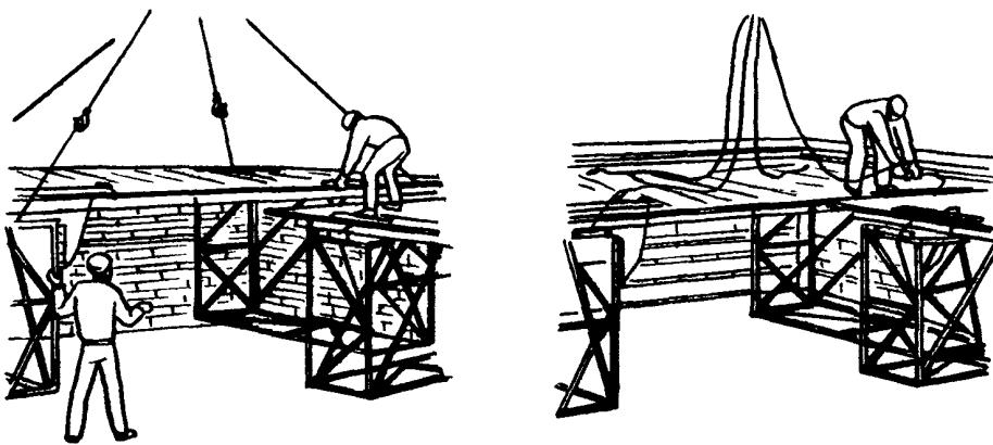
После полного раскрытия опор монтажник  $M_2$  и такелажник  $T_3$  следят за установкой подмостей на перекрытие, при необходимости регулируя ломами их положение. Затем они поднимаются по приставной лестнице на подмости и расстроповывают их, опуская петли в углубления подмостей
